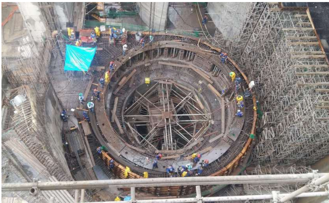
Figura 34 – Vista superior da caixa espiral em montagem
